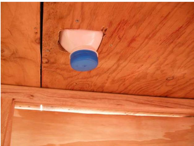
Anexos 3, 4 y 5: Detalle bebedero situado en el interior de los cajones con sistema de vaciado-llenado para renovación diaria.
